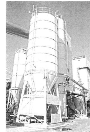
粉体サイロをA、B両プラントで共用できるように改造した
